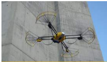
Inspection du Viaduc de Millau
