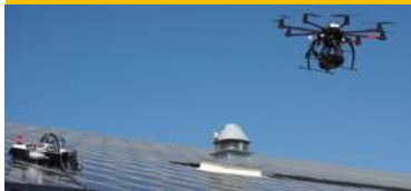
Vérification modules photovoltaïques par thermographie aérienne (EDF ENR)
