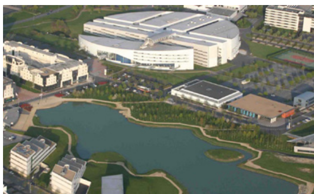
Vue aérienne du site ENSMA (crédit MJ Pichon)
