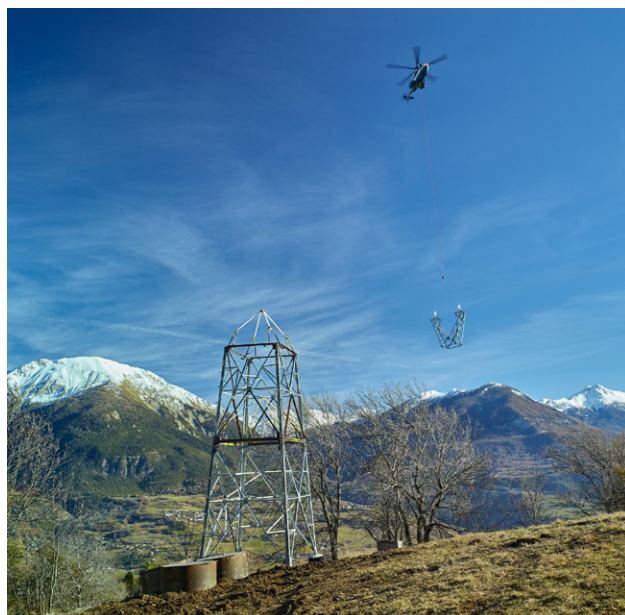
Figure 3. Travaux de levage de pylônes par tronçons au H225. © Julien Botella.
