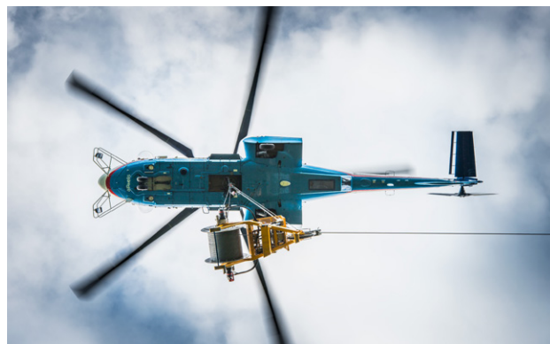
Figure 4. Travaux de déroulage de câbles au H225. © Julien Botella.
