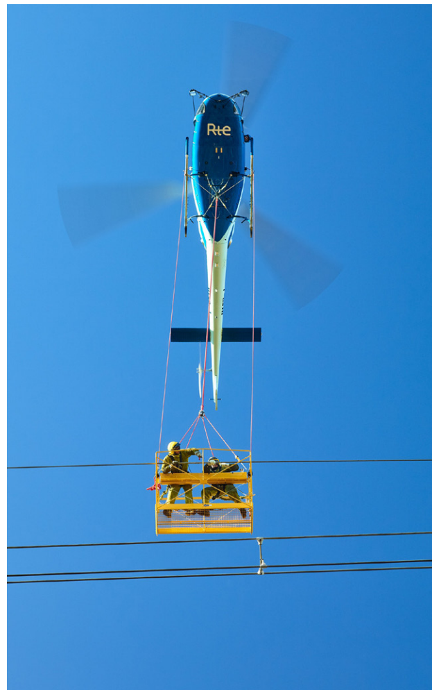
Figure 1. Travaux nacelle sous AS335N. © Julien Botella.
