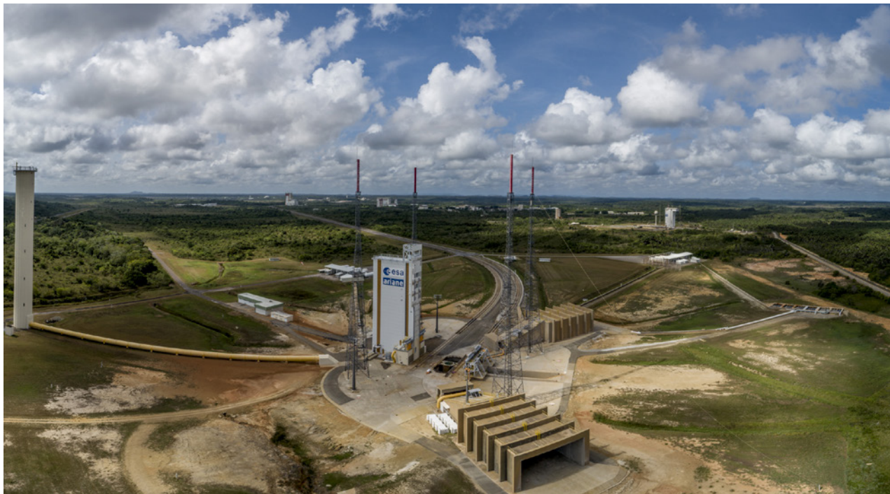
Vue sur le pas de tir Ariane 5. Au loin : le pas de tir de Vega et les bâtiments de préparation Ariane 5.
